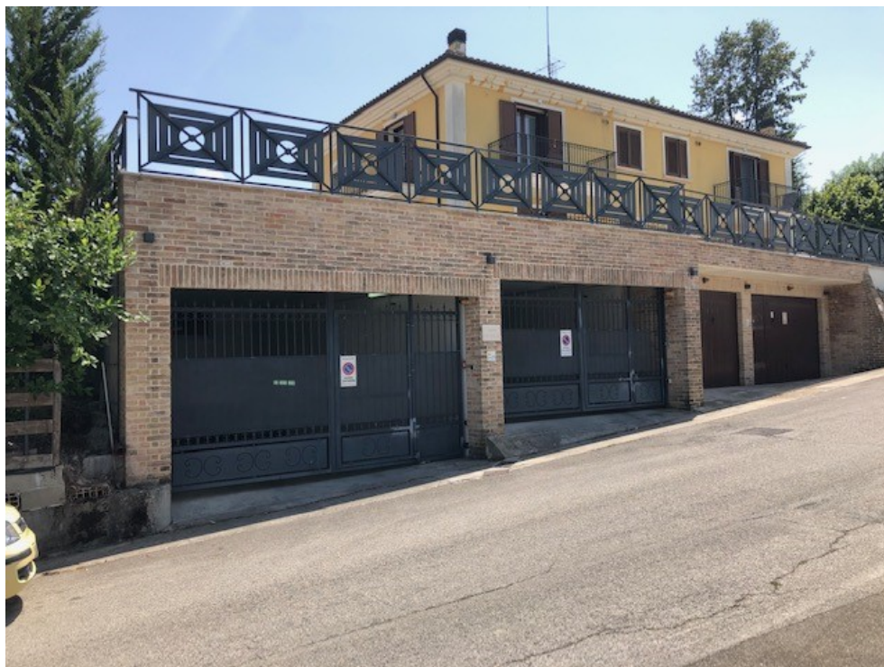
Ingresso carrabile all'autorimessa da Via Circonvallazione Nord
