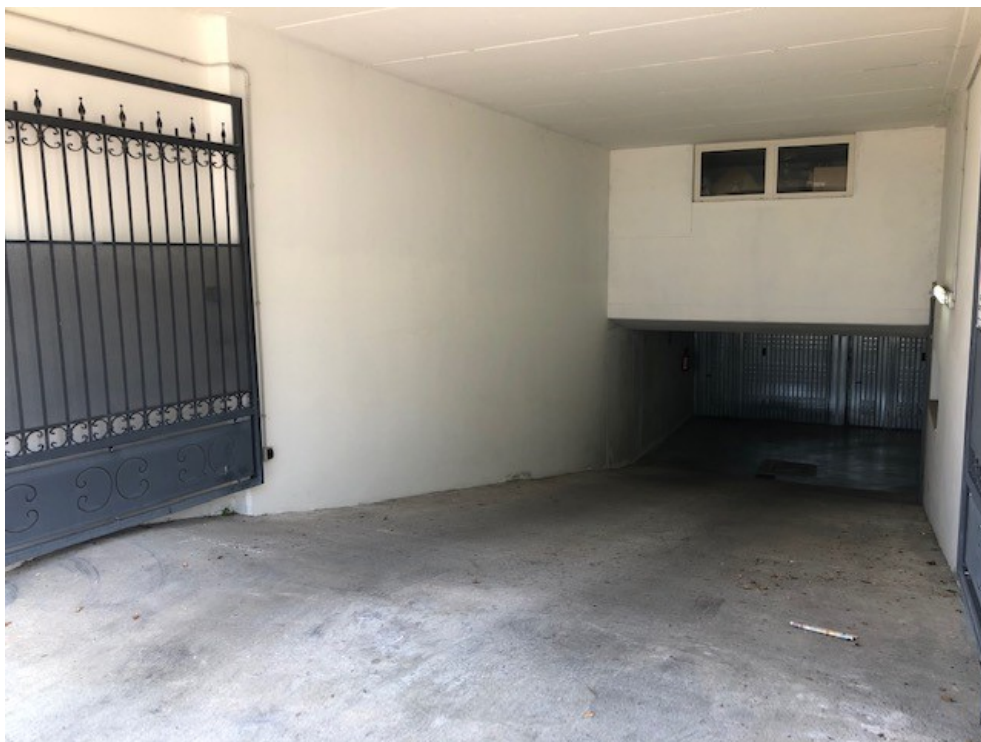
Rampa di accesso all'autorimessa
