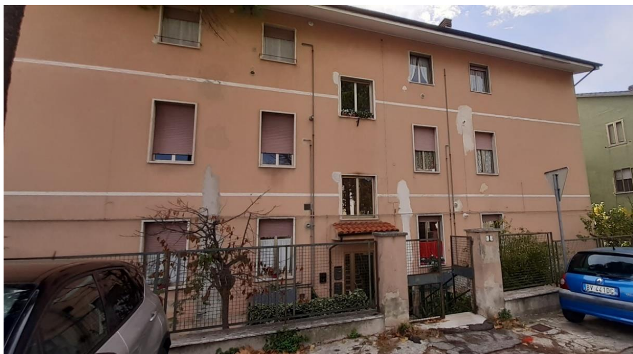
Prospetto nord alla palazzina ed ingresso da Via Domenico Tinozzi
