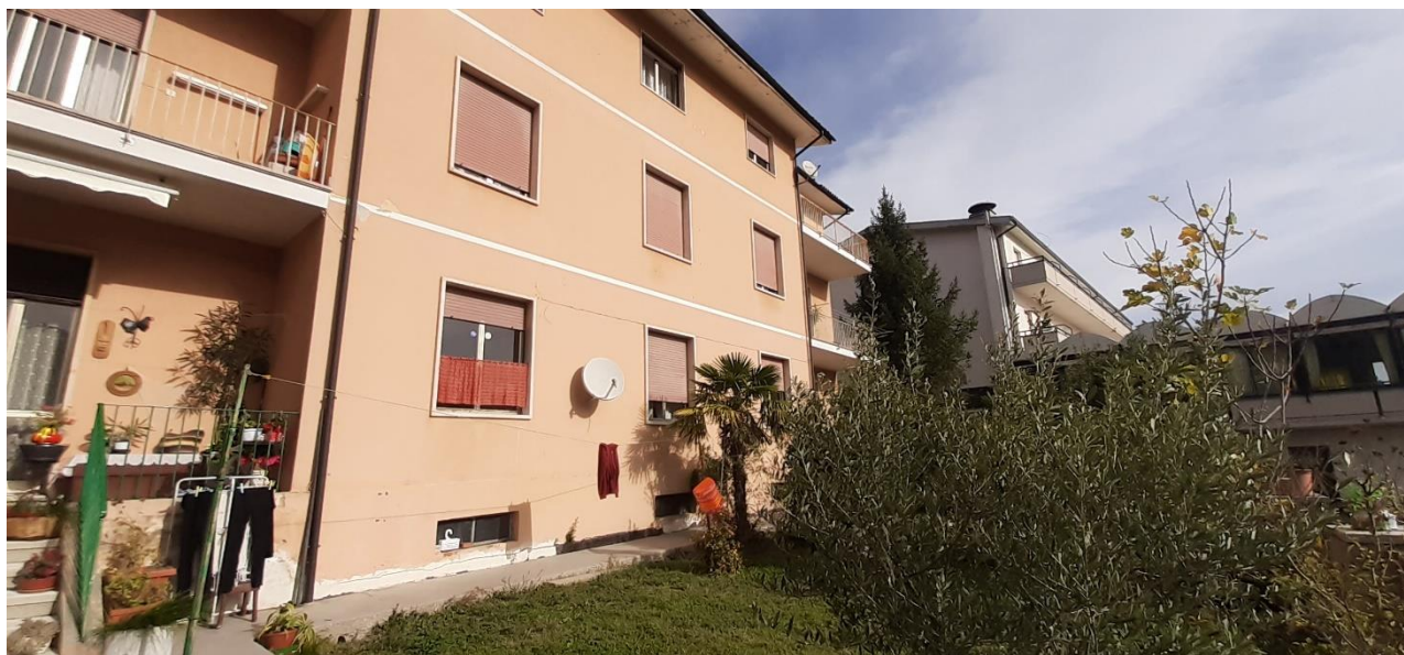
Prospetto sud della palazzina e giardino di pertinenza
