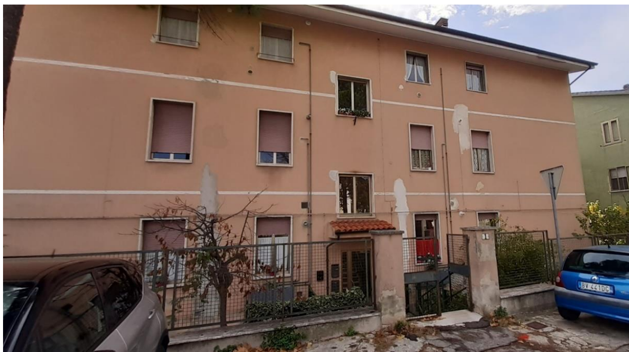
Prospetto nord della palazzina ed ingresso da Via Domenico Tinozzi
