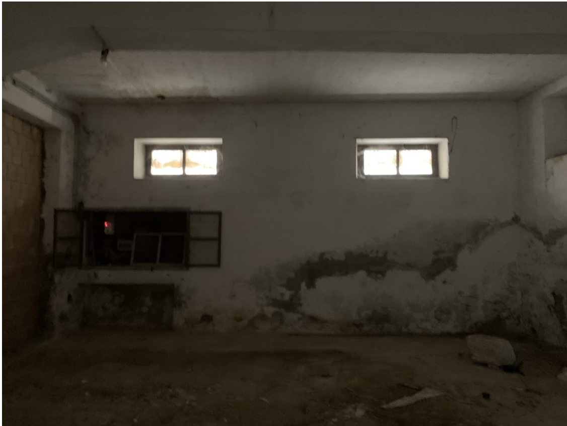
Foto Interne Piano terra
